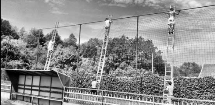
Výstavba ochranných sietí
